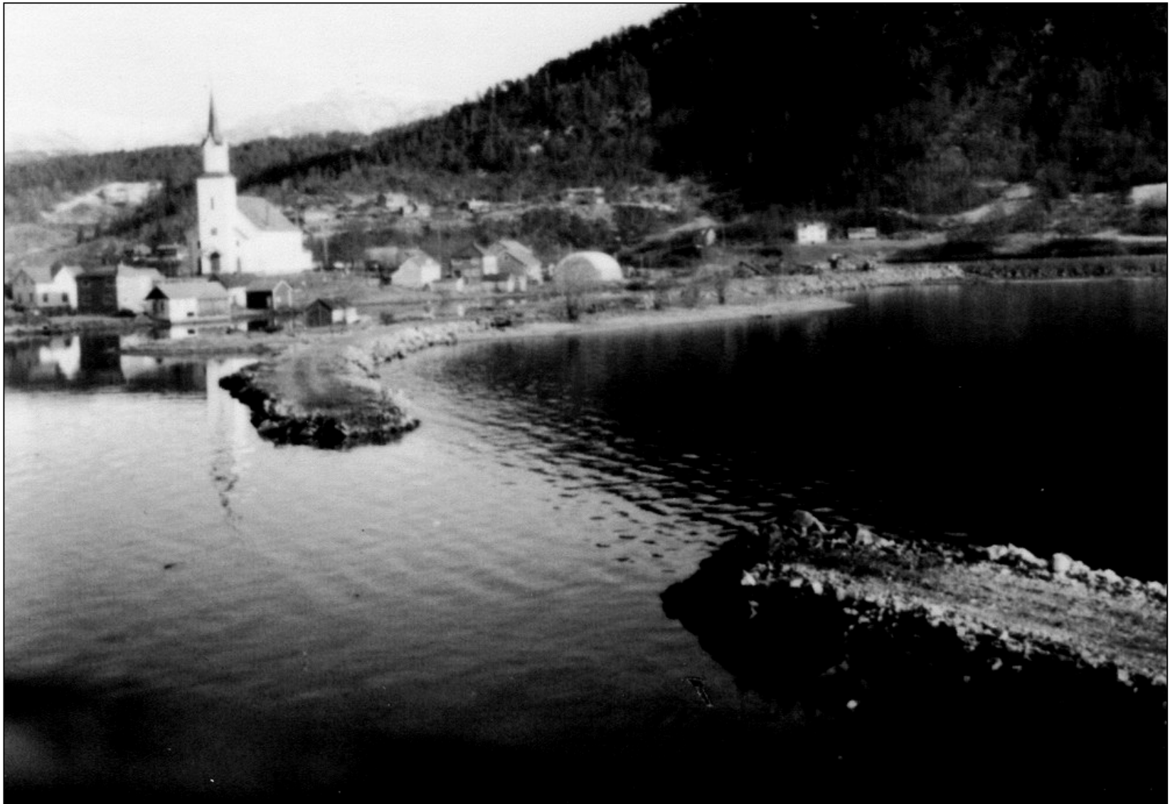
"16 Nyevegen over Naustøyra.jpg" Nyevegen forbi Meieriet og over Naustøyra er nesten ferdig utfyllt. Fotograf Gunhild Mallasvik. NFS.
